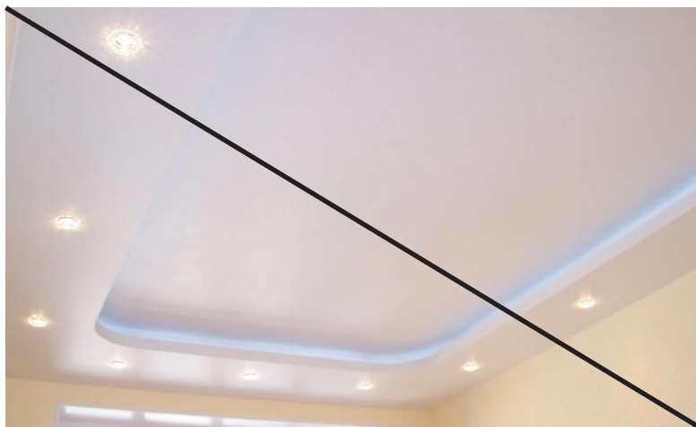
Плохо Многоуровневые гипсокартонные конструкции
