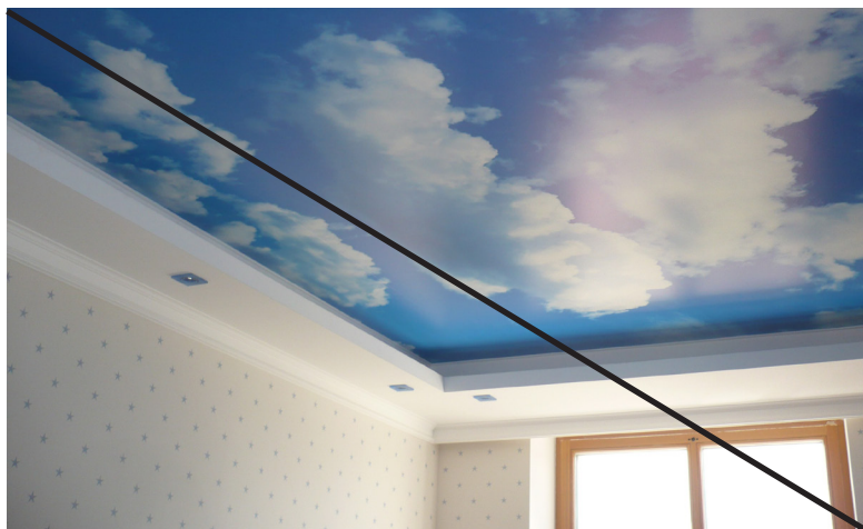
Плохо Натяжные потолки. Потолки с рисунками
